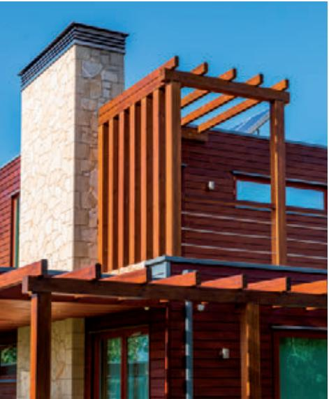
Les maisons ITS™, montées avec les deux faces des murs finies, peuvent être livrées entièrement équipées, avec la menuiserie extérieure incluse, ainsi que les canaux pour l'installation électrique intégrée, offrant un temps d'exécution rapide sans aucun temps de prise ou de séchage caractéristique d'une filière dite humide (construction traditionnelle).
